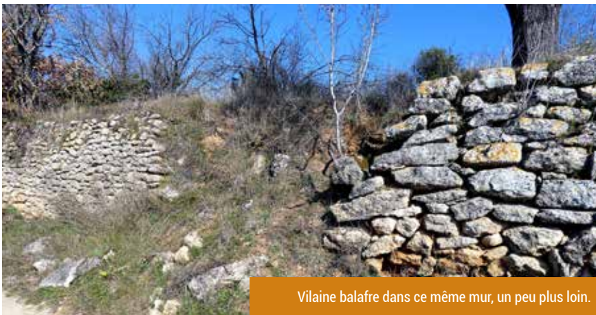
Pan de mur en pierres sèches en bon état de conservation
